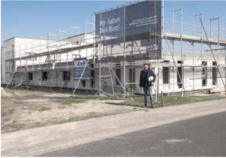
Es geht voran: Der Rohbau ist bald fertig – bereits zum 1. November sollen die neuen Mieter einziehen. Foto: Medienwerk15
